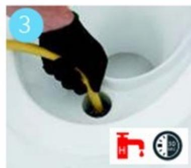
Lorsque l'eau/urine ne s'écoule pas du compartiment à urine, cela indique l'accumulation de dépôts urinaires (comme indiqué sur la photo 1.). Si vous ne le retirez dans les délais impartis, vous risquez de boucher le drain et de provoquer une situation encore plus grave. Pour éviter cela, nettoyez le conduit d'évacuation de l'urine une fois tous les six mois et autant que possible.
