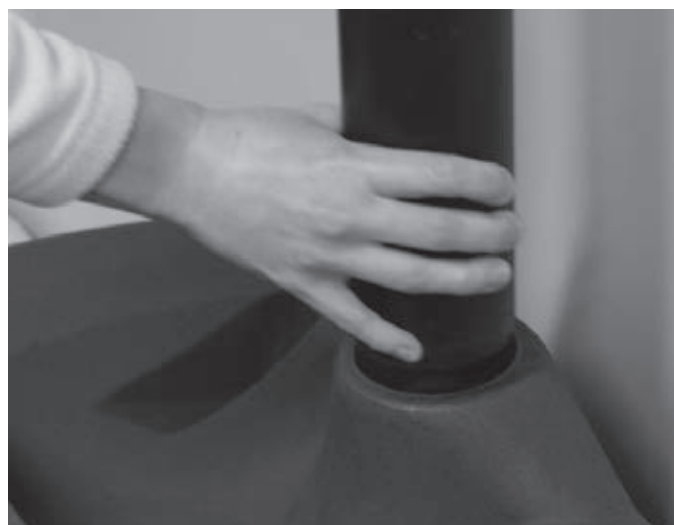
3. Odlączenie rury wentylacyjnej
