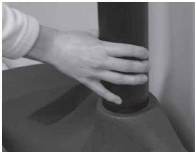
3. Desconexión de la tubería de ventilación
